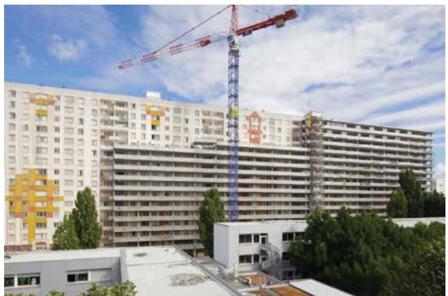
Detalj s gradilišta snimljen prilikom montaže konstrukcije od predgotovljenih AB elemenata
