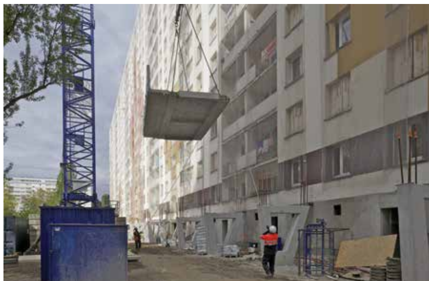
Detalj s gradilišta
